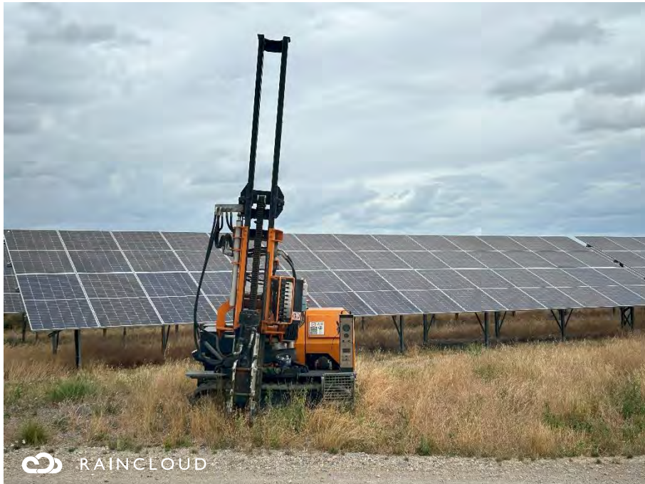
Plate 12-23 Mini pile driver examples
